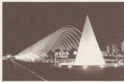
El nou Museu de les Ciències de l'arquitecte Calatrava, València (Foto: Josep Puigbo)
